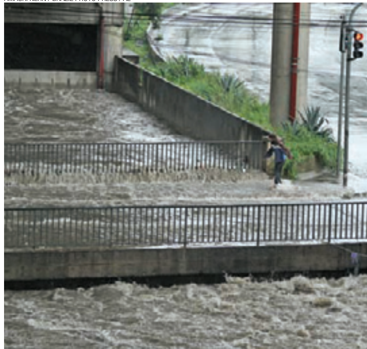
Forças das águas - Córrego Sacomã transbordou perto da Via Anchieta
