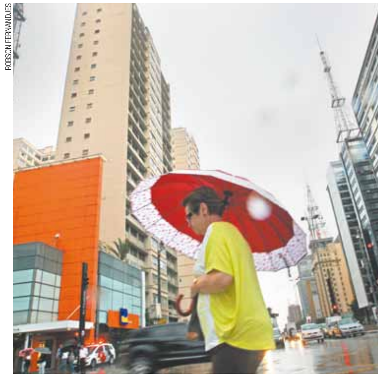
Perigo - A chuva ocasionou 13 pontos de alagamento pela cidade
