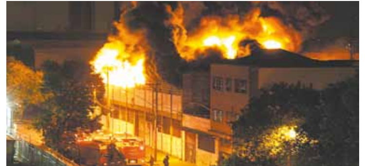
Chamas altas - Prédio da fábrica foi totalmente consumido pelo fogo
